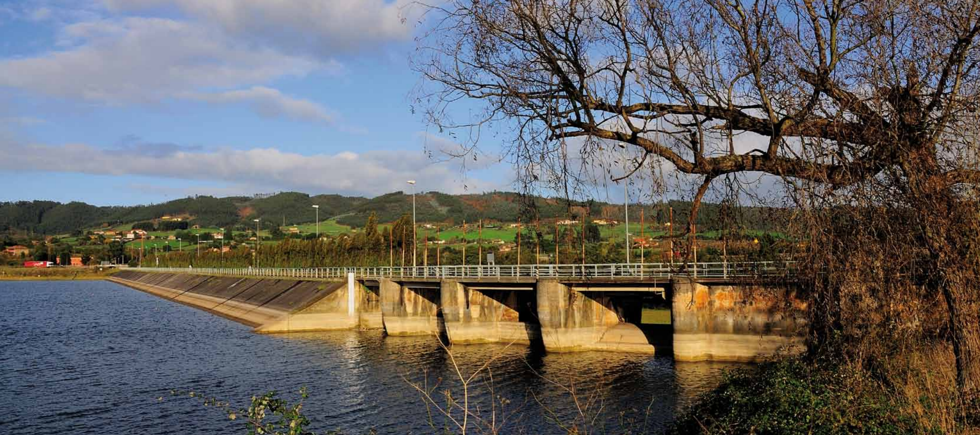
Auscultation of the San Andrés, La Granda y Trasona dams of Arcelor
