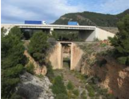
Vallmelós Ravina Viaduct
